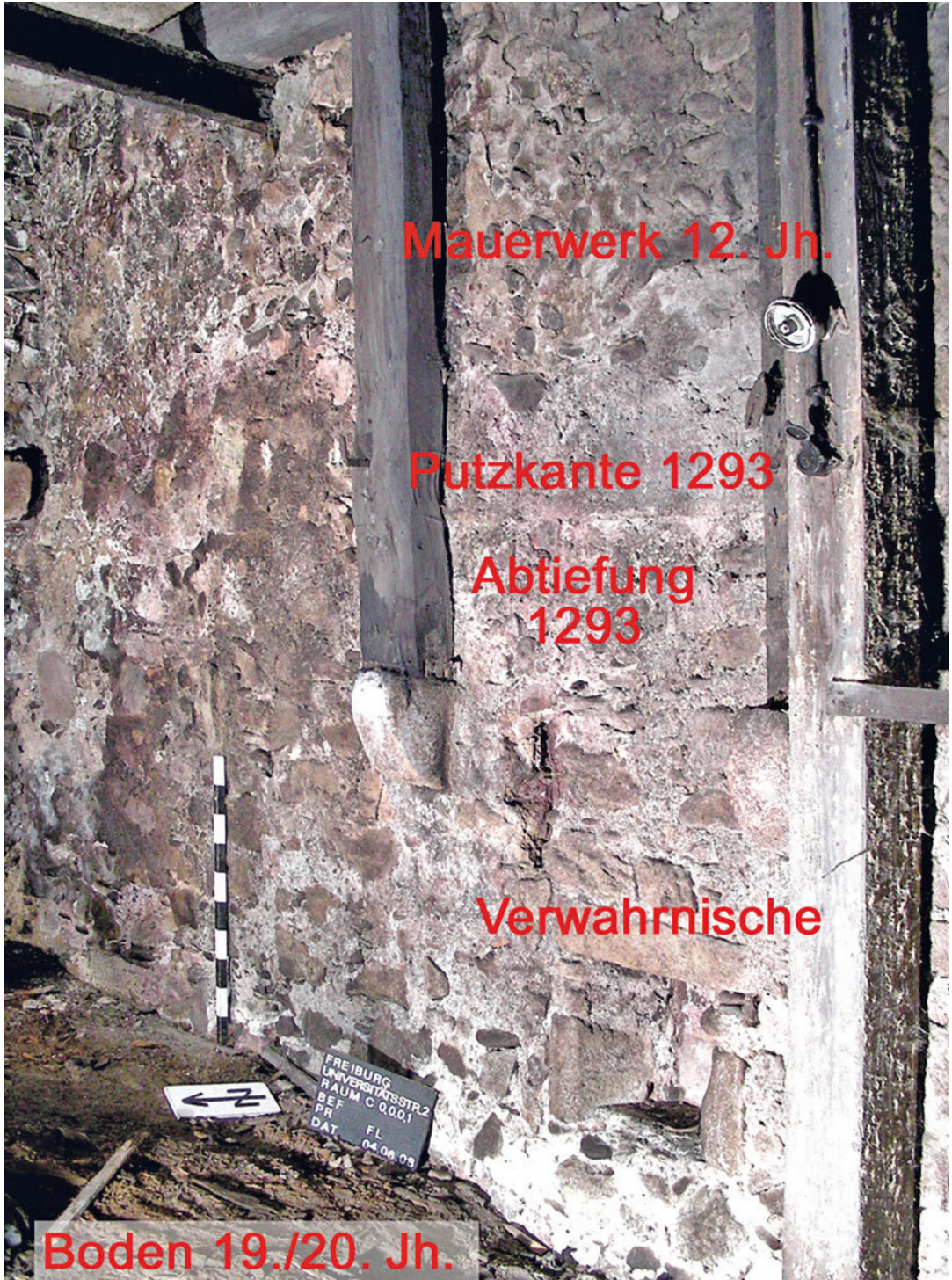
Abb. 5 Freiburg, Universitätsstr. 2. Kellermauer des 12. Jahrhunderts, darunter Mauerwerk der Abtiefung von 1293 mit Konsolsteinen für die damals eingebaute Zwischendecke (Foto: Frank Löbbbecke).
