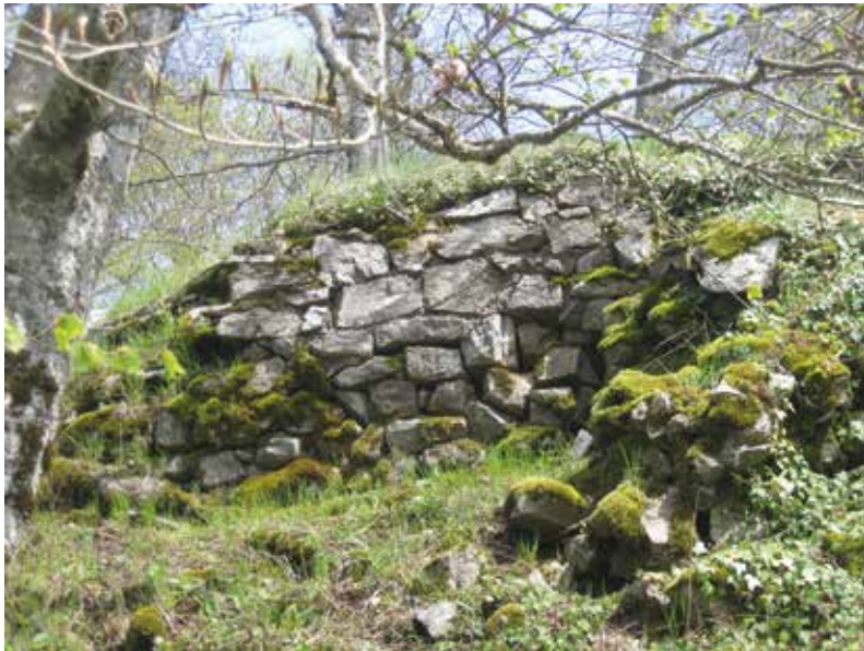
Abb. 2 Mauerschale an der Außenseite der Oberburg, an ihrem südwestlichen Rand (Foto: Heiko Wagner).
