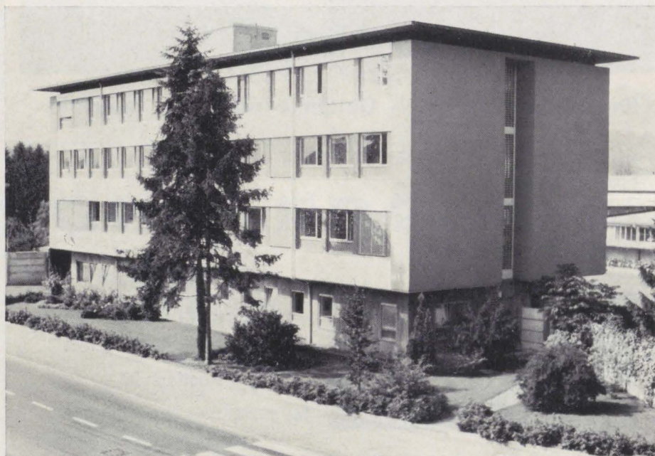
Modernes Industriegebäude in Bretten – ausgeführt von Fa. Metz, Bretten
