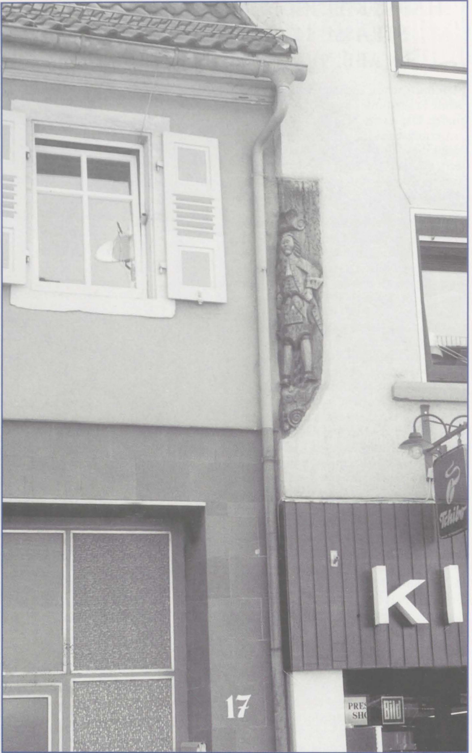
(Abb. 10) Haus Melanchthonstraße 19
