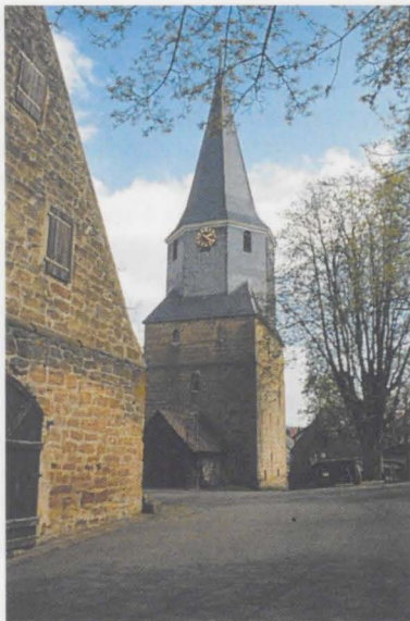
Abb. 7: Der heutige Glockenturm. Deutlich ist der Baubestand des Burgturmes an dem massiv gemauerten, mächtigen Turm ablesbar.
