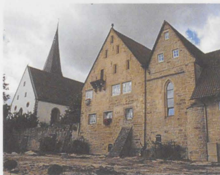
Abb. 8: Front des Amtshauses und der ehemaligen Kapelle von Osten
