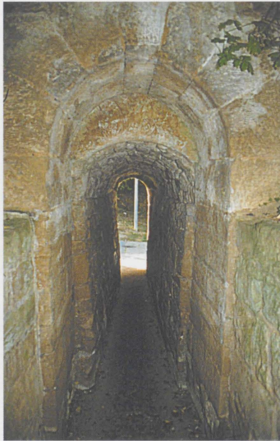
Abb.19: Blick in das Gewölbe des sogenannten Teuchelloches
