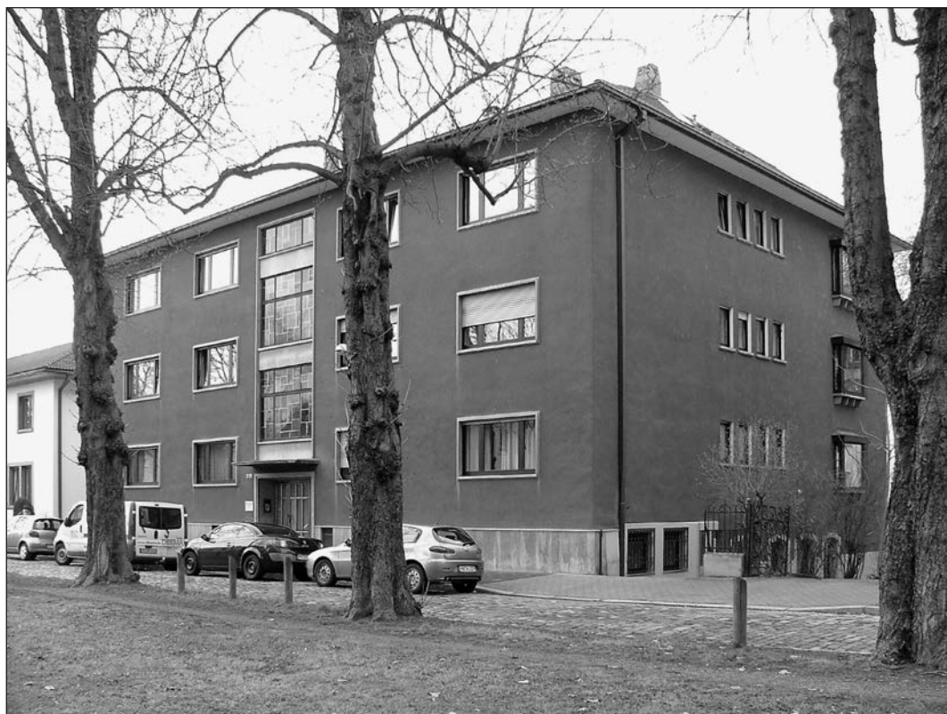
Das Wohnhaus in der Werderstraße 57, Januar 2008
