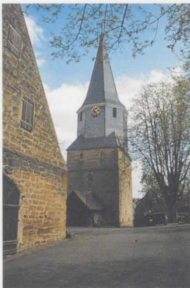
Abb. 7: Der heutige Glockenturm. Deutlich ist der Baubestand des Burgturmes an dem massiv gemauerten, mächtigen Turm ablesbar.
