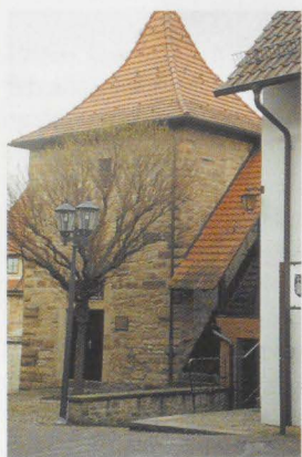
Abb.14: Der Hexenturm von der Innenseite der Anlage her gesehen
