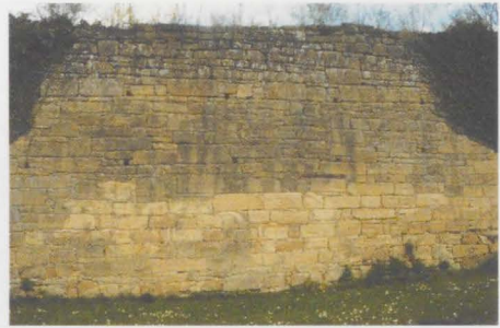
Abb.16: Die Amtshofmauer im südwestlichen Abschnitt. Deutlich ist die ursprünglich saubere Mauertechnik mit den Gerüstbolzlöchern zu erkennen
