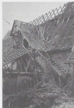
Abb.12: Der äussere Treppenaufgang an der Zehntscheuer zu Beginn der Sanierungsarbeiten
