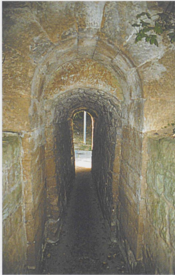
Abb.19: Blick in das Gewölbe des sogenannten Teuchelloches
