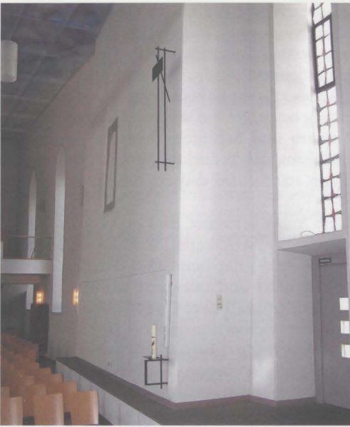
Blick auf die ins Kirchenschiff hineinragende Südwestseite des Kirchturms.
