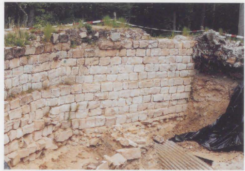
Innenseite der Ringmauer des Schlössels bei Klingenstein aus sorgfältig gesetzten Handquadern.
