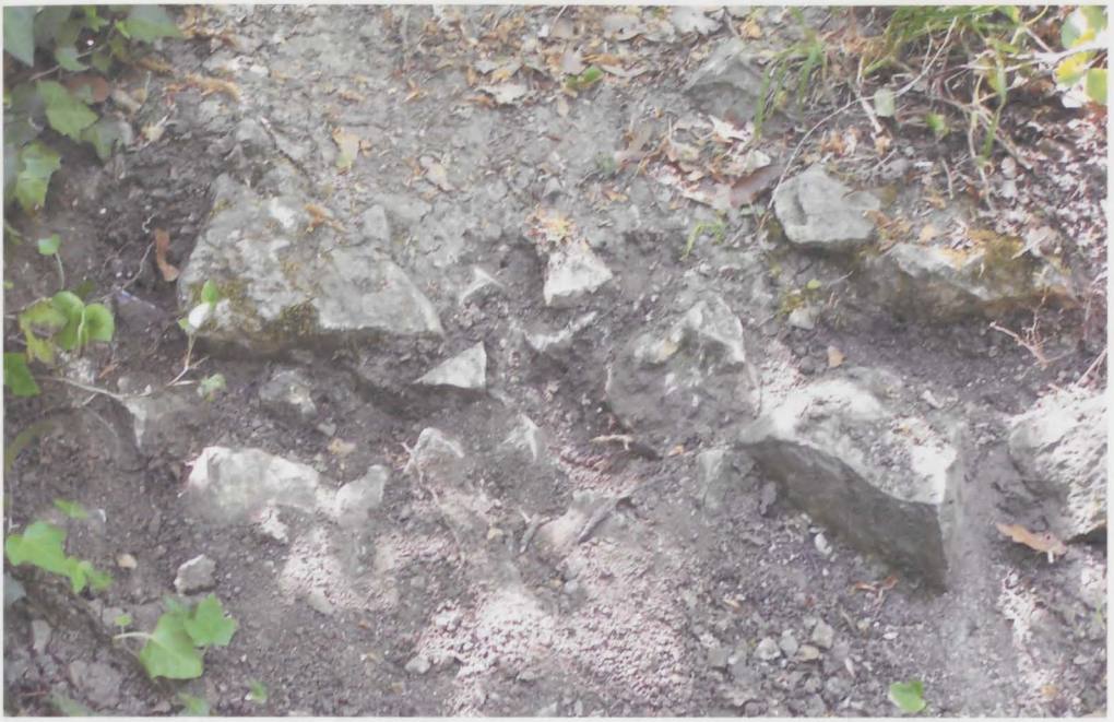
Füllmauerwerk der Ringmauer.
