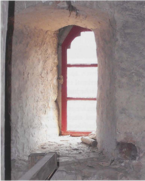
Zum Fenster umgebauter Lichtschlitz. Die trichterförmig nach innen erweiternde Flucht der alten Laibung ist noch gut erkennbar.
