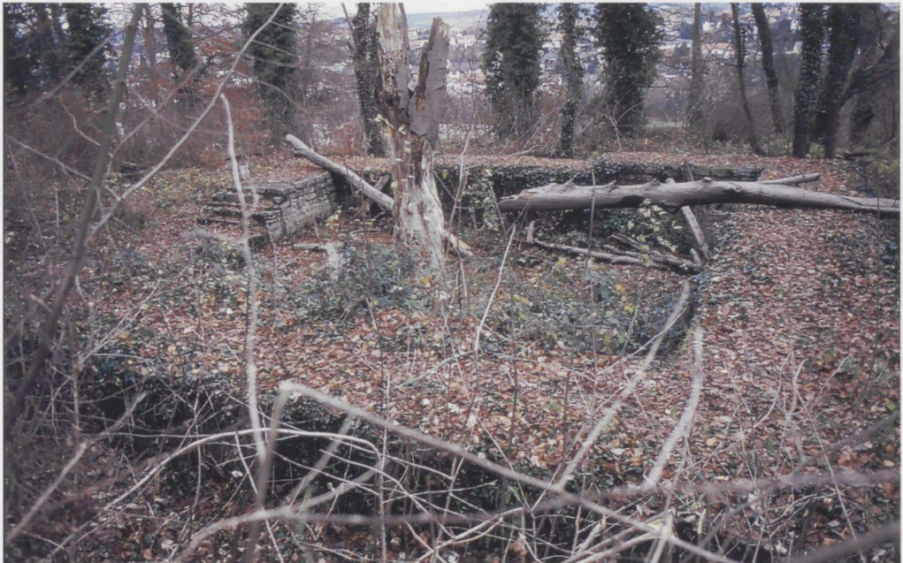
Abb. 9: Die Ruine des Wobnturms im Brettener Burgwäldle
