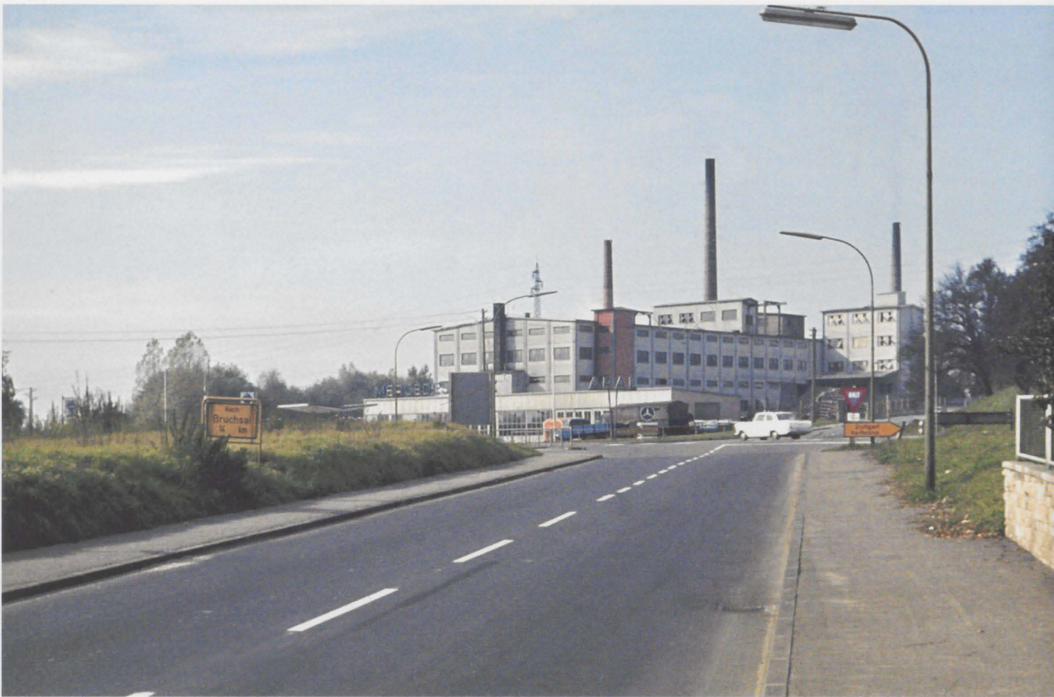
Schornsteine und Fabrikationsgebäude des Steinzeugwerks Harsch dominierten 1967 die Diedelsheimer Höhe.
