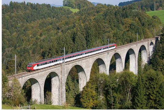
**Abb. 5b:** Bahnhofviadukt der SOB bei Degersheim, aufgebaut mit Quadern aus Appenzeller Granit.
