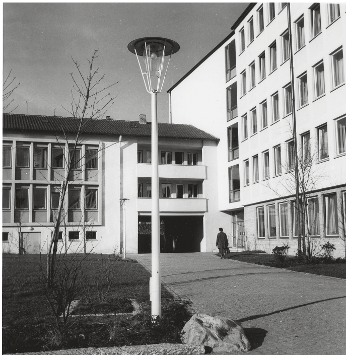
Abb. 57: Das neue Rathaus in Friedrichshafen, Standort der Vereinsbibliothek von 1958 bis 1968. – Stadtarchiv Friedrichshafen, A 3/II/85. Bildarchiv Foto Marburg, Archivnr. 765.942.
