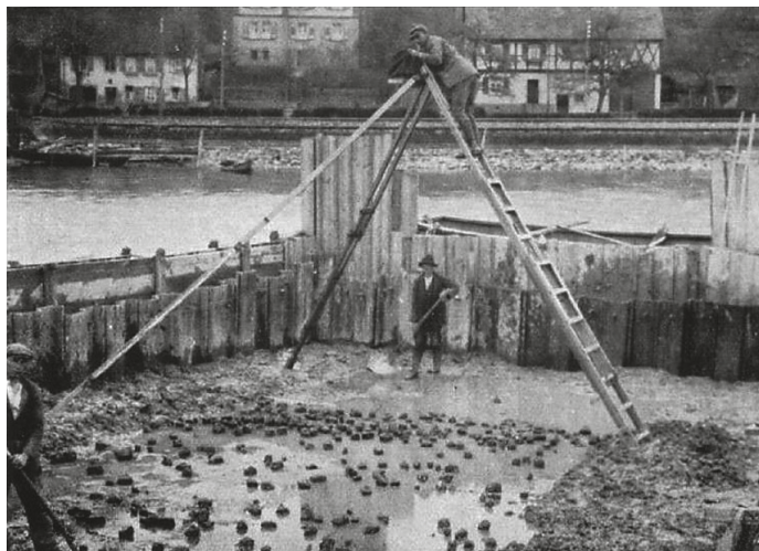
Abb. 38: Die Ausgrabung der Pfahlbaustation vor Sipplingen im Jahre 1929 wurde vom Bodensee-Geschichtsverein angeregt und mitgetragen. Die Durchführung lag bei Hans Reinerth, dessen innovativer Kastendamm (»Grabungskasten«) die Anwendung professioneller Grabungsmethoden in der Flachwasserzone des Sees erlaubte, hier die planphotographische Aufnahme vom Leiterstativ aus. – Schrr VG Bodensee 59 (1932) Taf. 7.
