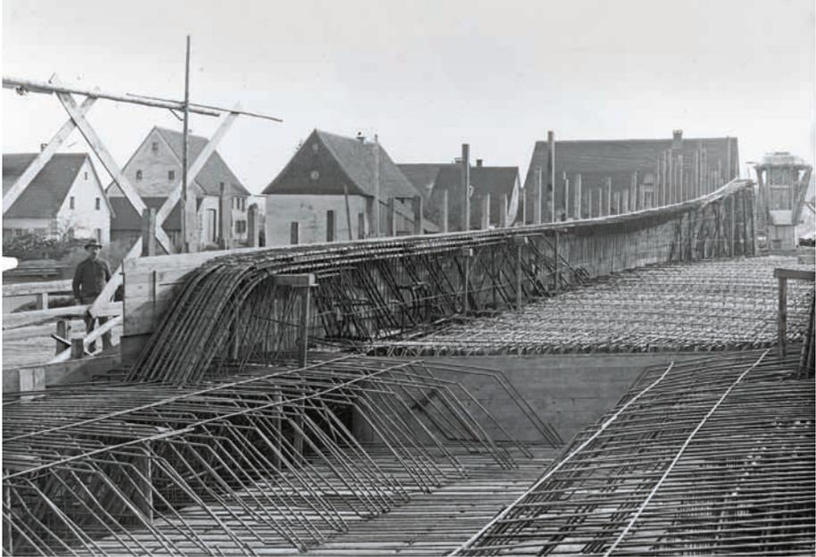
Die Brücke über die Breg (Nordbrücke) während der Erbauung, aufgenommen von Norden, vom heutigen Rathaus aus. Deutlich zu erkennen sind die Armierungen für den Hauptträger in der Seitenwange (links), der tief in die Gegengewichte im Böschungsbereich (vorne) eingreift und für die Bodenplatte, die die Fahrbahn trägt (rechts).
