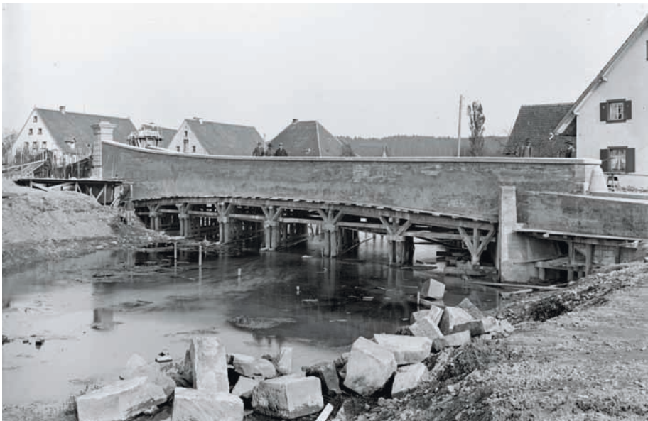
Die Brücke über den Flutkanal (Südbrücke) mit Lehrgerüst, aufgenommen von Westen.
