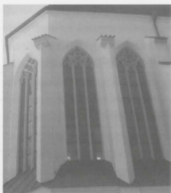
Abb. 6: In Bayern herrschte vor 1400 ein Baustil mit verkürzten Strebepfeilern vor wie hier am Chor der St.-Johannes-Kirche (begonnen 1319) unmittelbar vor dem Freisinger Dom. Bemerkenswert sind auch die dreieckig zulaufenden Strebepfeilerprofile, die hier zum ersten Mal auftreten (Foto: Verfasser).
