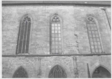
Abb. 25: St. Martin in Amberg, Nordseite. Zu sehen sind (von links nach rechts) das Vierpassmaßwerk, die Baunaht zwischen den beiden Bauabschnitten und die Lisenen mit Dreiecksprofil am jüngeren Westteil (Foto: Verfasser).
