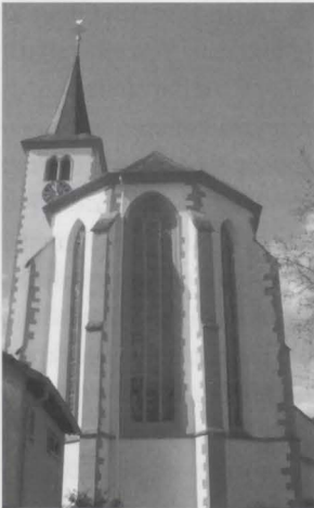
Abb. 24: Als Pfalzgraf Otto 1410 Mosbach zum Sitz seines neuen Herzogtums machte, ließ er an der fast fertiggestellten Stiftskirche St. Juliana nach Heidelberger Vorbild die Strebepfeiler am Chor unterhalb der Traufe enden (Foto: Verfasser).
