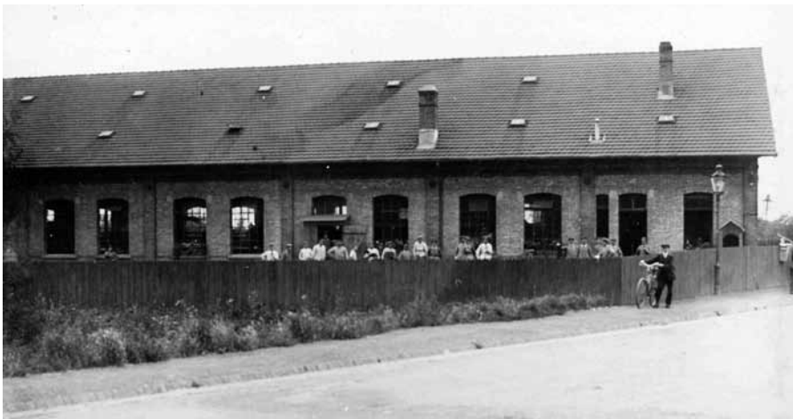
Blank'sche Fabrik in der Hölderlinstraße (heute Gleisdreieck zwischen Römerstraße und Hebelstraße). Endgültiger Standort des städtischen Kriegsgefangenenlagers ab Juli 1916. Ab Februar 1916 wurde das Gebäude auch als Rekrutendepot der 2. Ersatzabteilung eines Jägerbataillons 14 verwendet. Das Bild zeigt vermutlich die militärische Einheit.
