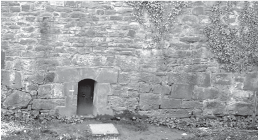
Abb. 5: Brunnenstube in der Stützmauer (17. Jahrhundert) (Foto: Verfasser)
