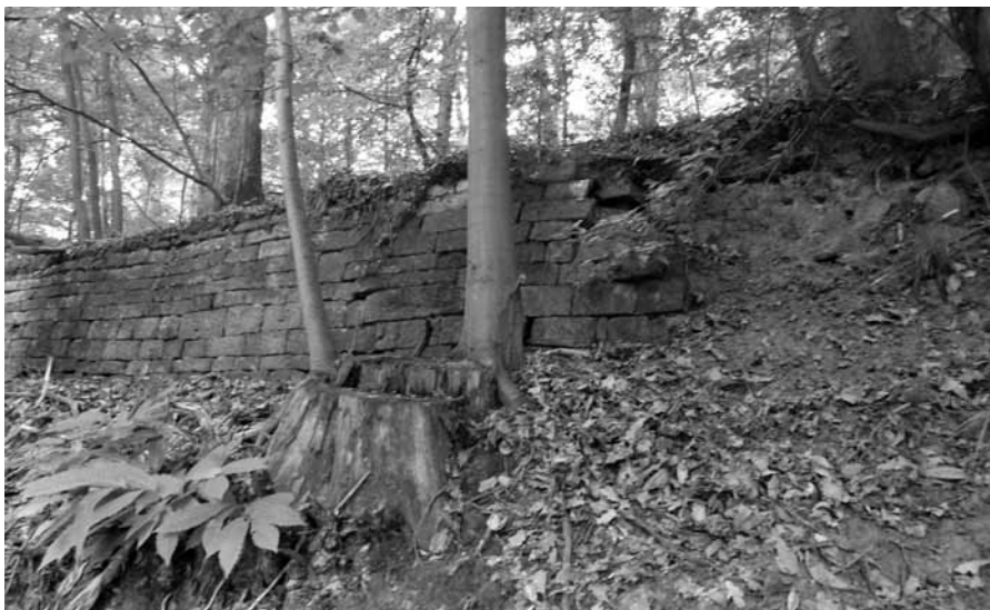
Abb. 7: Rest einer trockenen Stützmauer an der „oberen Stufe“ oberhalb des Gaiberger Wegs (Foto: Verfasser)
