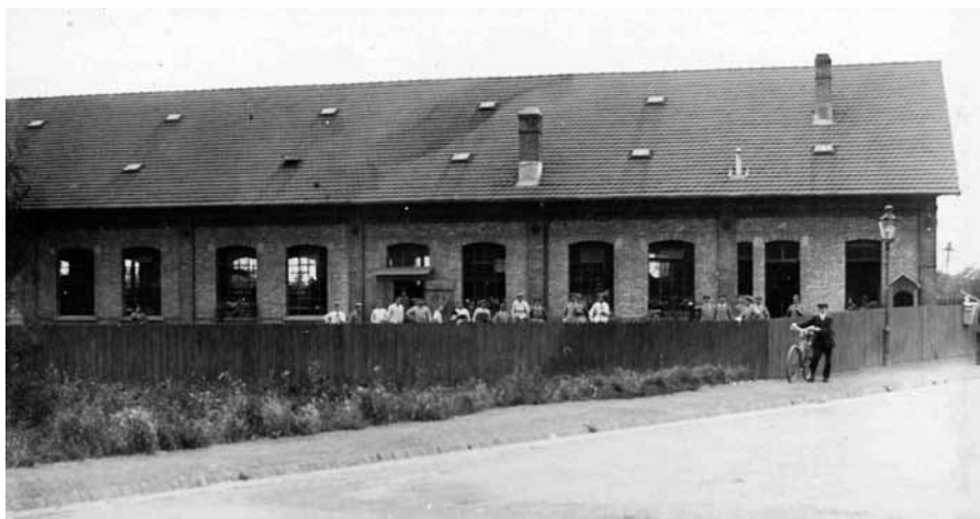
Blank'sche Fabrik in der Hölderlinstraße (heute Gleisdreieck zwischen Römerstraße und Hebelstraße). Endgültiger Standort des städtischen Kriegsgefangenenlagers ab Juli 1916. Ab Februar 1916 wurde das Gebäude auch als Rekrutendepot der 2. Ersatzabteilung eines Jägerbataillons 14 verwendet. Das Bild zeigt vermutlich die militärische Einheit.
