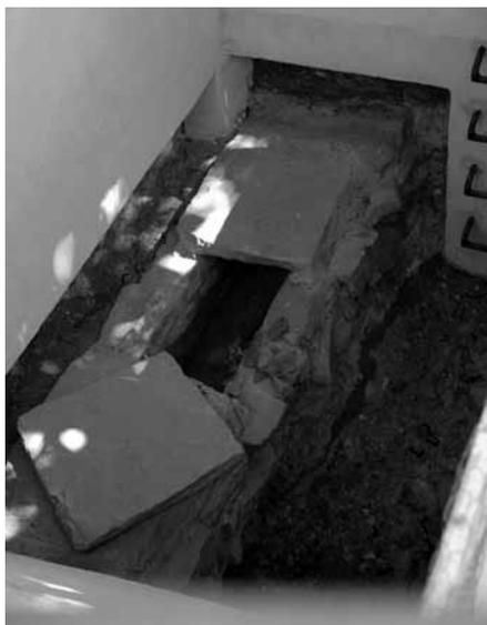
Abb. 1: Blick in die Fundstelle in Eppelheim: der gemauerte Wasserleitungs-Kanal, teilw. geöffnet (Foto: Ludwig Schmidt-Herb)
