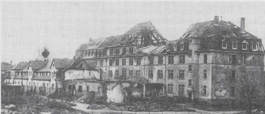
Der Dachstuhl des ehemaligen Artilleriegebäudes wurde beschädigt.
