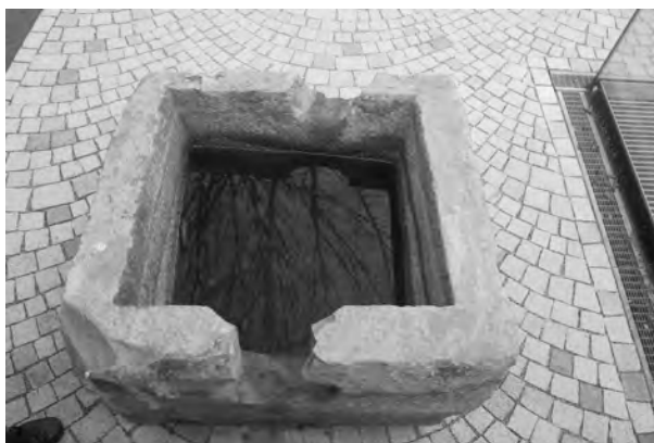
„Steinsarg“ wie von Traitteur seine großen Sandabscheider in seinen Plänen von 1798 nannte. Er steht heute neben dem Eingang zum Rohrbacher Bürgeramt. (Foto: Nestler)
