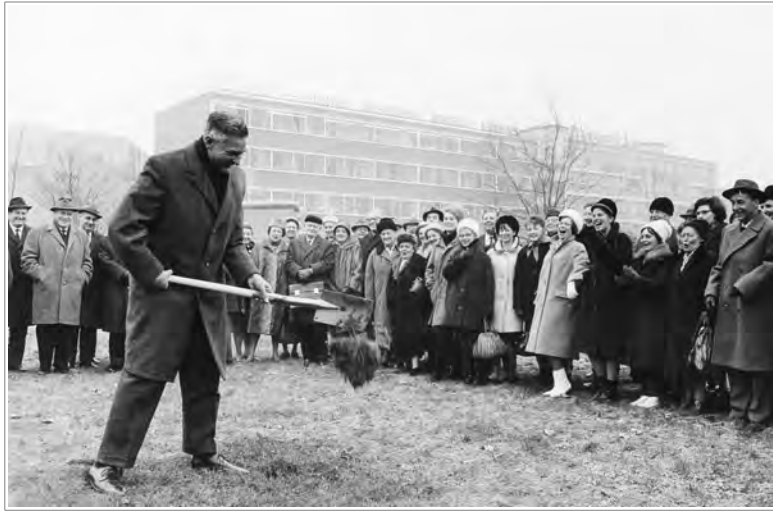
Erster Spatenstich durch OB Robert Weber (Foto: Stadtarchiv Heidelberg Bildsammlung)
