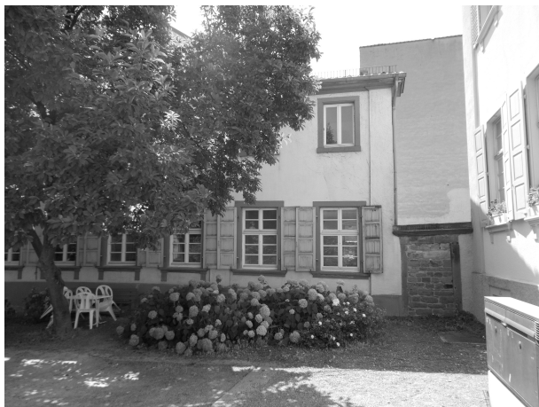
Der Flügelbau des Schmitthennerhauses heute (Foto: Jo-Hannes Bauer)
