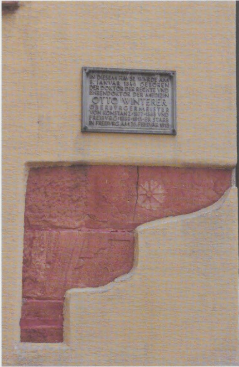
Sandsteinbauteil am Erdgeschoss des Hauses. Vermutlich wurden beim Wiederaufbau nach dem Dreißigjährigen Krieg im unteren Bereich des Hauses alte Steine verwendet. Die oberen Geschosse bestehen aus Fachwerk.
