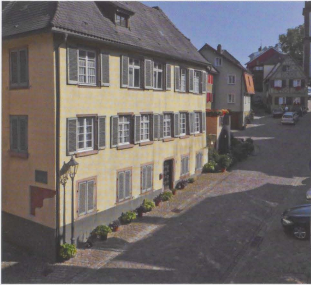
Ehemaliges Stadtschreibereihaus (heutiger Zustand).
