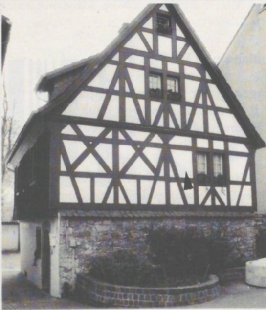
Abb. 1: Gebäudeansicht von Nordosten, Zustand nach Sanierung 1998; Gefachfeld mit Krugdarstellung aus der Bauzeit 1601 (Pfeil)
