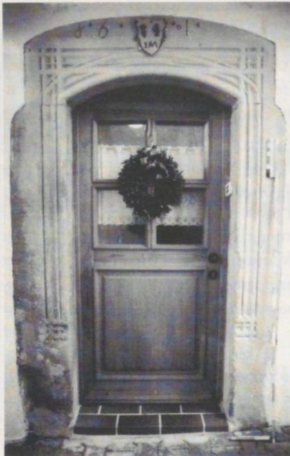
Abb. 2: Zugangstür mit stabprofiliertem Sandsteingewände; Jahreszahl, Krug, Faßbahn und Initialen im Sturzgewände
