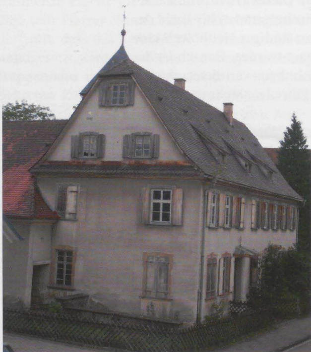
Das alte katholische Pfarrhaus vor der Renovierung.
