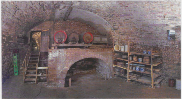
Der zweite große Kellerraum unter dem Wohnhaus. Aufn. Wolfgang Hoffmann
