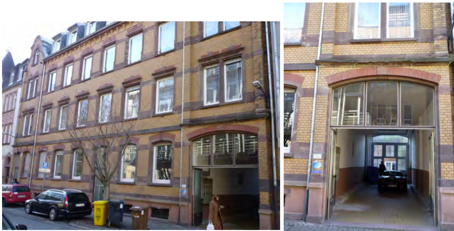
Gebäude Kirchstraße 18–20, rechts Hofeinfahrt (heutiger Zustand) (Foto: privat)
