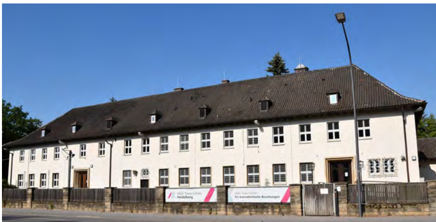
Ansicht des MTC von der Römerstraße aus (Quelle: Mark Twain Center)
