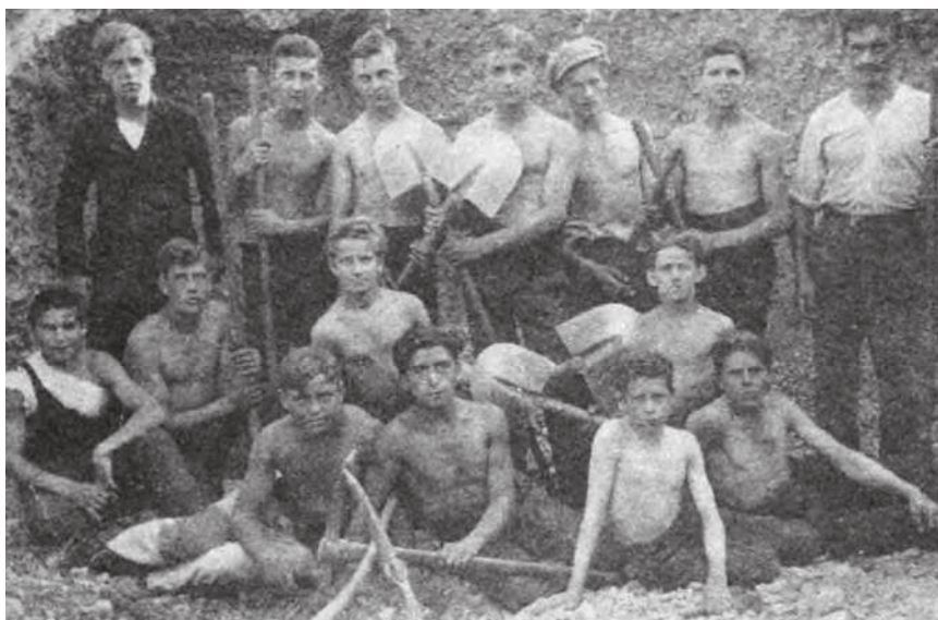
Jung und Alt helfen selbstlos beim Aufbau der Siedlung – so jedenfalls die genossenschaftliche Idealvorstellung. (Quelle: Baugenossenschaft Neu-Heidelberg)
