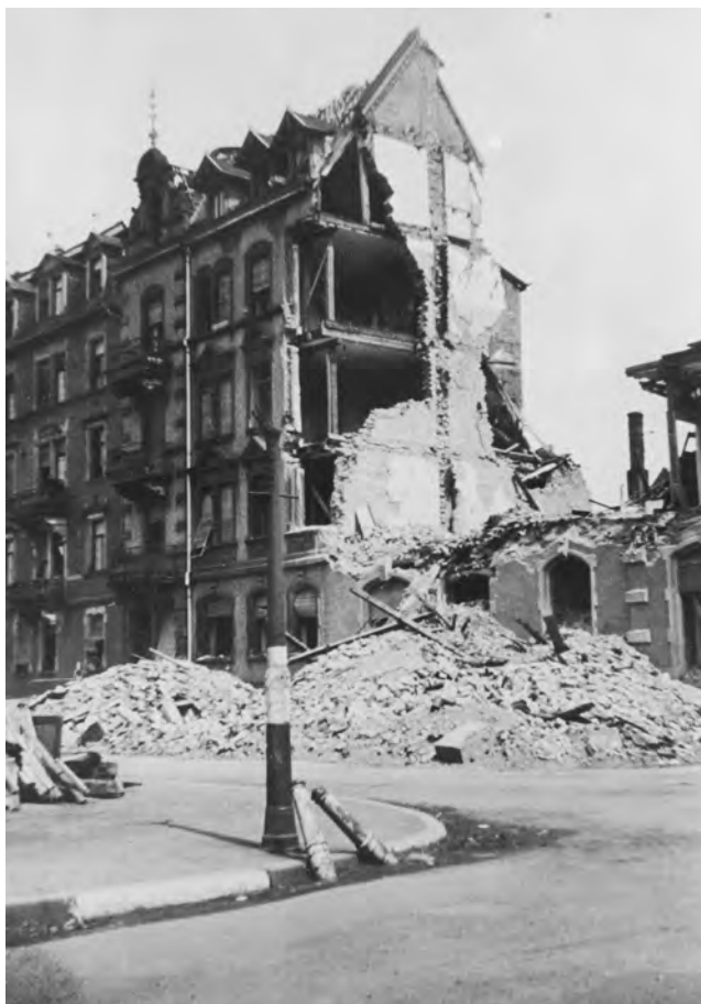
Bombenschaden Ecke Mittermaier- straße 27/Alte Eppelheimer Straße 48 (Foto: privat)
