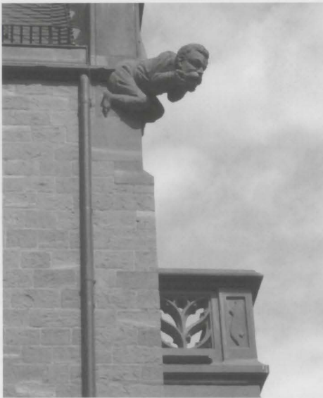
Villa Remler – Detail der Fassade (Foto: Martin Blumröder)
