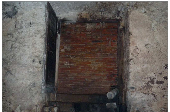
Zugemauerter Einstieg ▲
