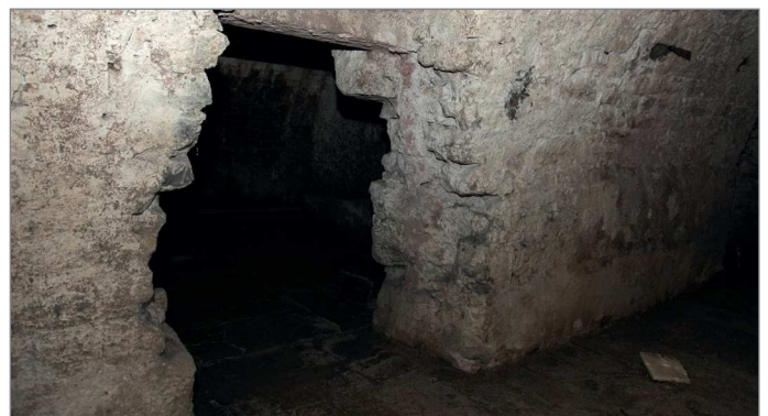
Mauerdurchbruch ▼
