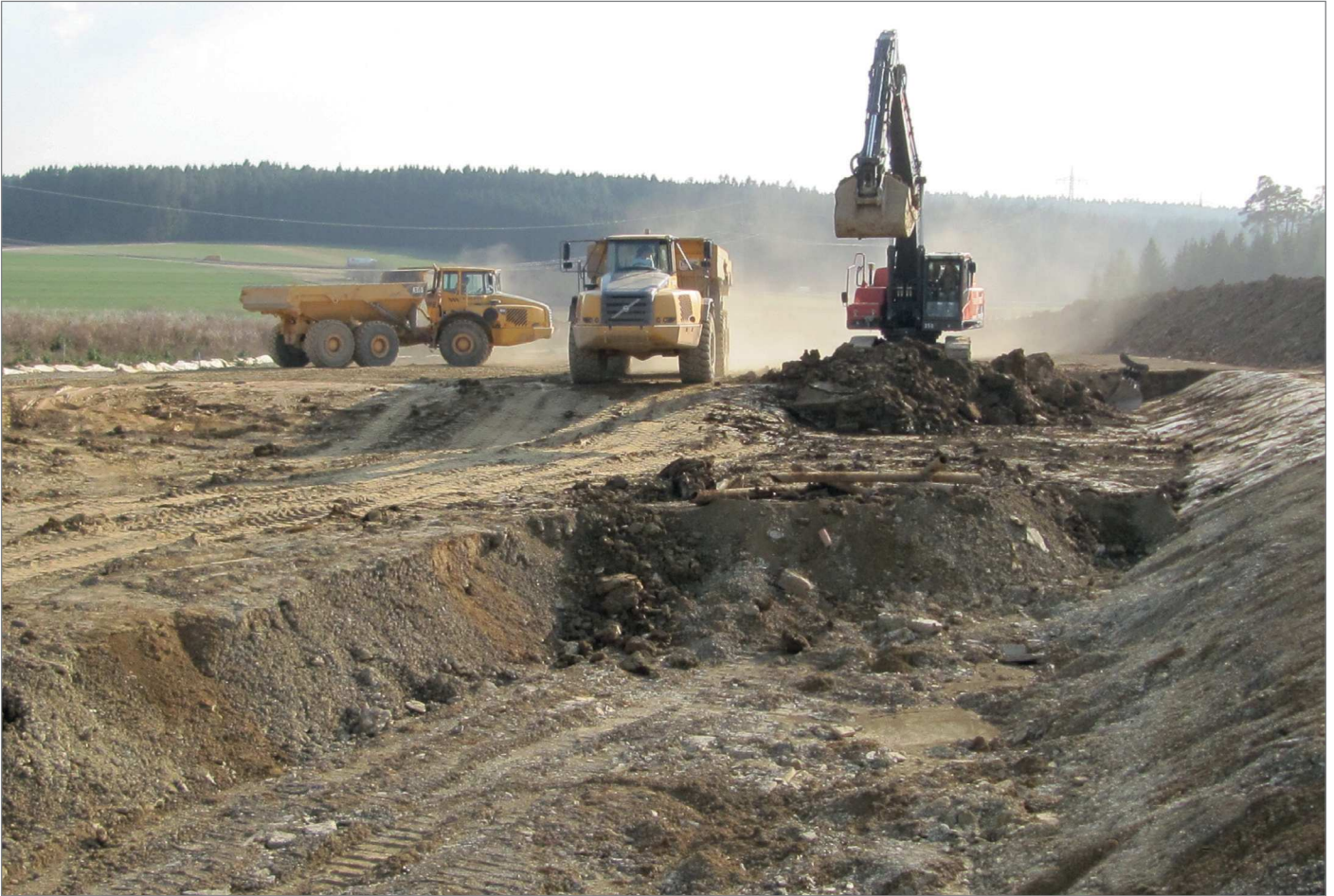
Herstellung vom Straßeneinschnitt, Bereich Bergwald ▲
