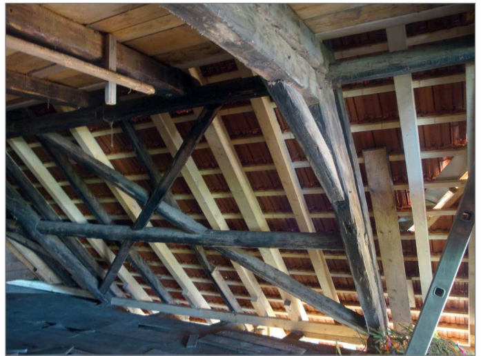
Baumaßnahmen – alt/neu, unter Ziegeldeckung ▲
