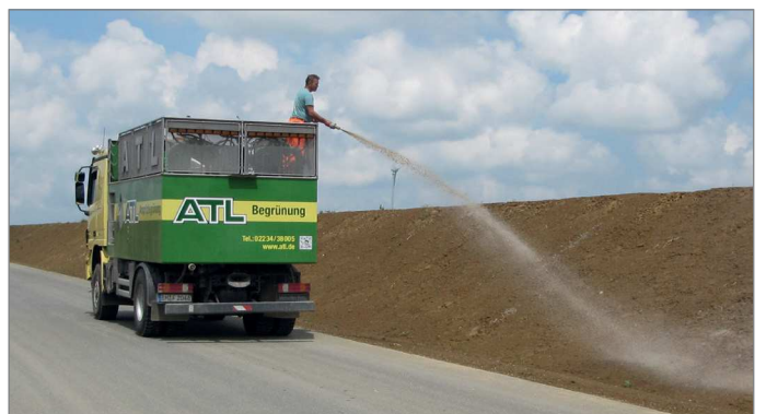
Humusierung der Straßenböschung bei der L422 Böschungsansaat im Anspritzverfahren ▲ ▼
