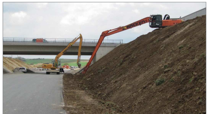
Humusierung der Straßenböschung bei der L422 Böschungsansaat im Anspritzverfahren ▲ ▼
