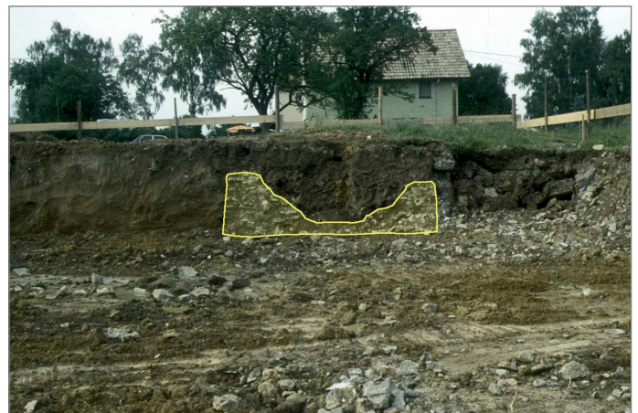
Abbildung 3: Nördliche Baugrubenkante 1991, gelb hervorgehoben: Reste von Kellermauerwerk ▼
