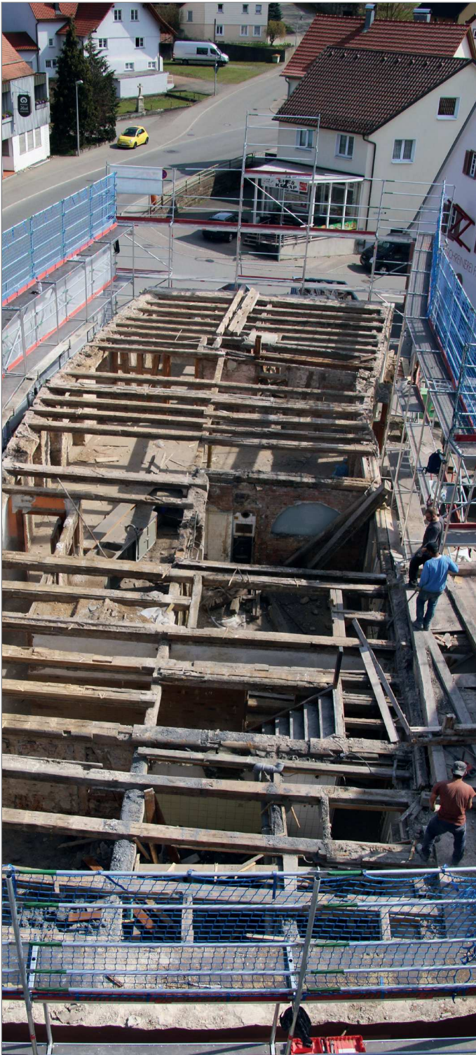
▼ Wehle beim Umbau nach dem Brand
