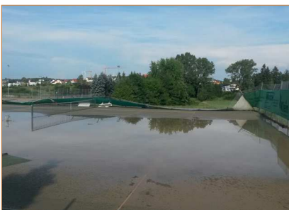
ZAUN- UND PLATZSCHÄDEN NACH DEM UNWETTER VOM 22.07.2015
