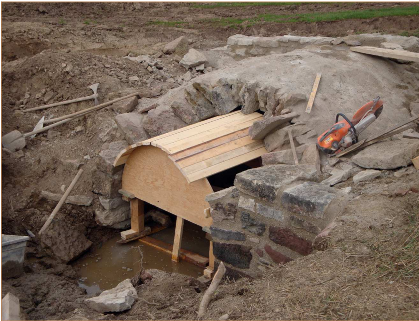
DIE SCHALUNG WIRD EINGEBAUT
