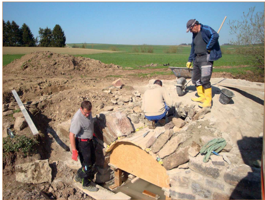
DIE AUSGESUCHTEN STEINE WERDEN MIT TRASS-KALK-MÖRTEL VERMAUERT
