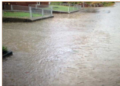
ÜBERFLUTUNG DER DORFBACHSTRASSE AM 22.07.2015
