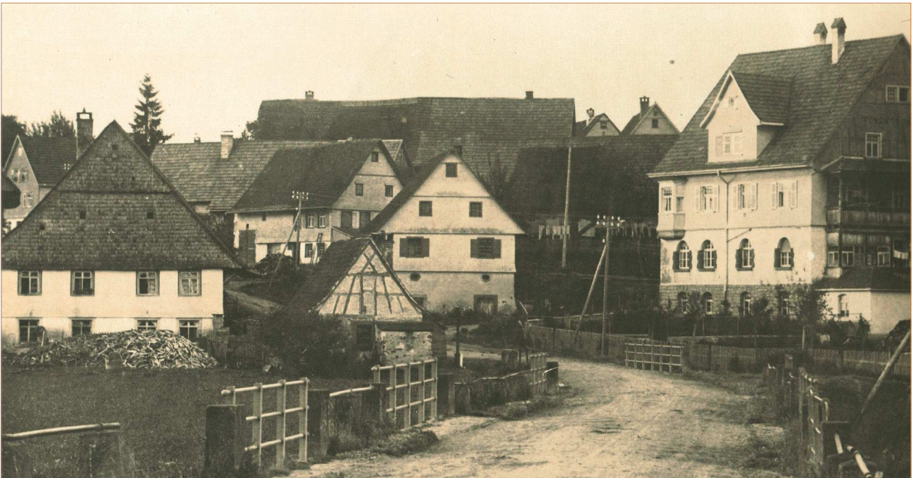
LOCHERHOFERSTRASSE, RECHTS EHEMALIGES GASTHAUS ANKER
