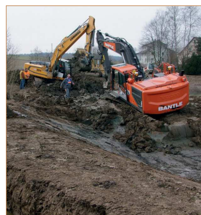
ERSCHWERTE BEDINGUNGEN BEIM AUSHEBEN DES NEUEN BACHLAUFS
