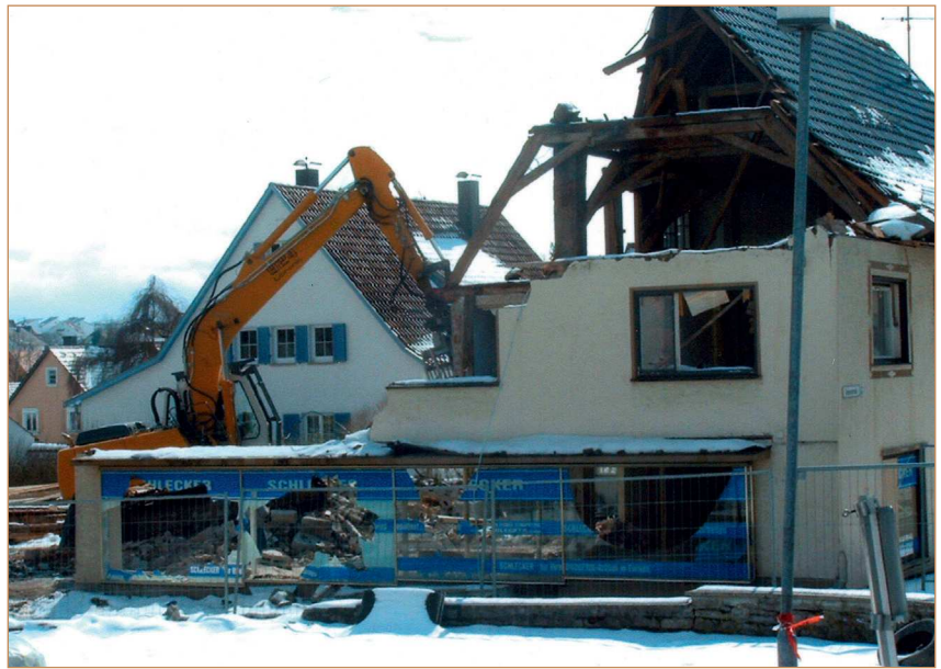
ABRISS: FOTO VOM 10.11.2008
