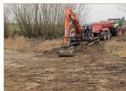
AUSRÄUMEN VON VERFÜLLUNGEN AM WASSERSEE (RICHTUNG BÖSINGEN LINKS)
