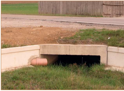
AMPHIBIENLEITEINRICHTUNG MIT DURCHLÄSSEN
