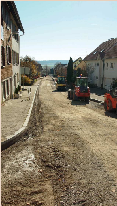
SANIERUNG DER LOCHERHOFERSTRASSE
