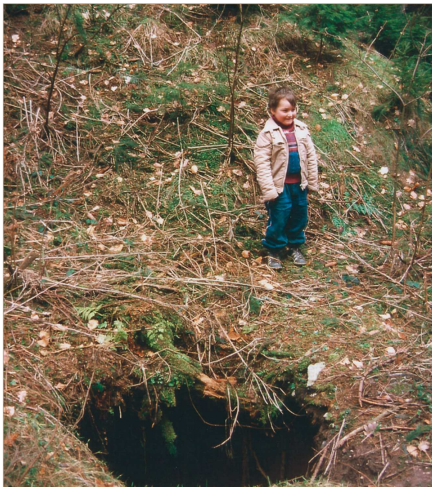
ABB. 3: ERDEINBRUCH ÜBER DEM STOLLEN
