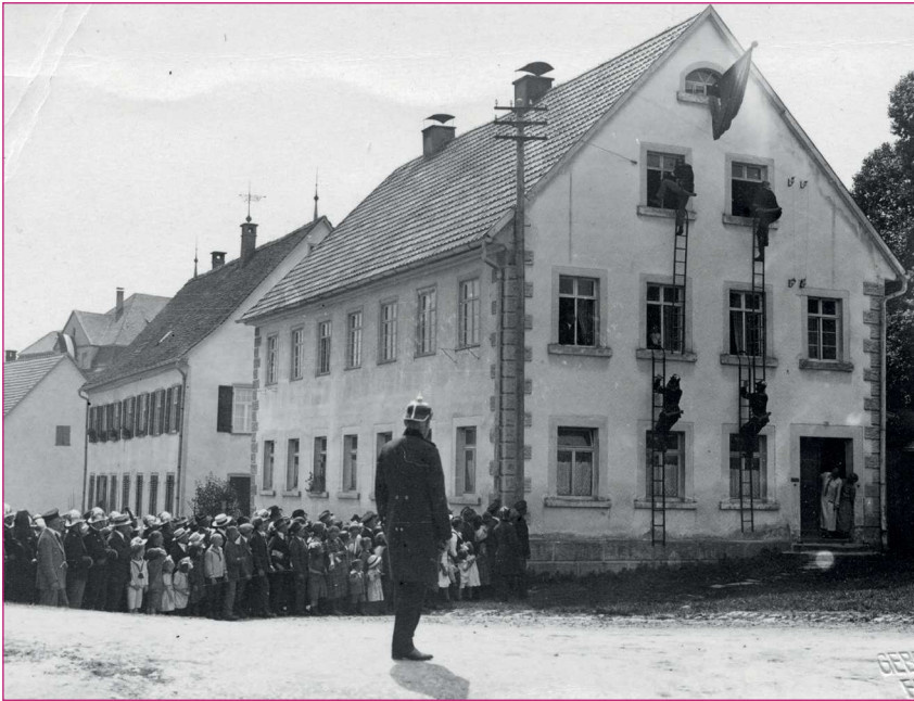
ÜBUNG DER STEIGER AM HAUS GRABENSTRASSE 2
