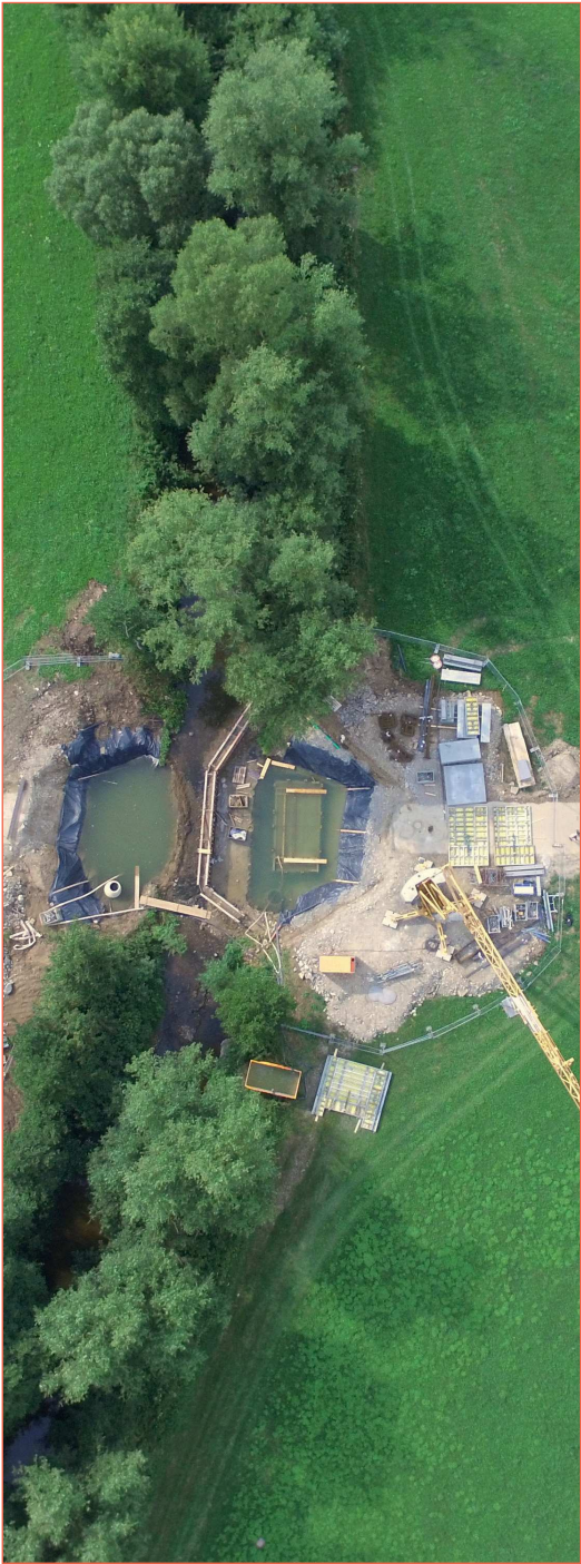
Bauarbeiten am Lösungswort
