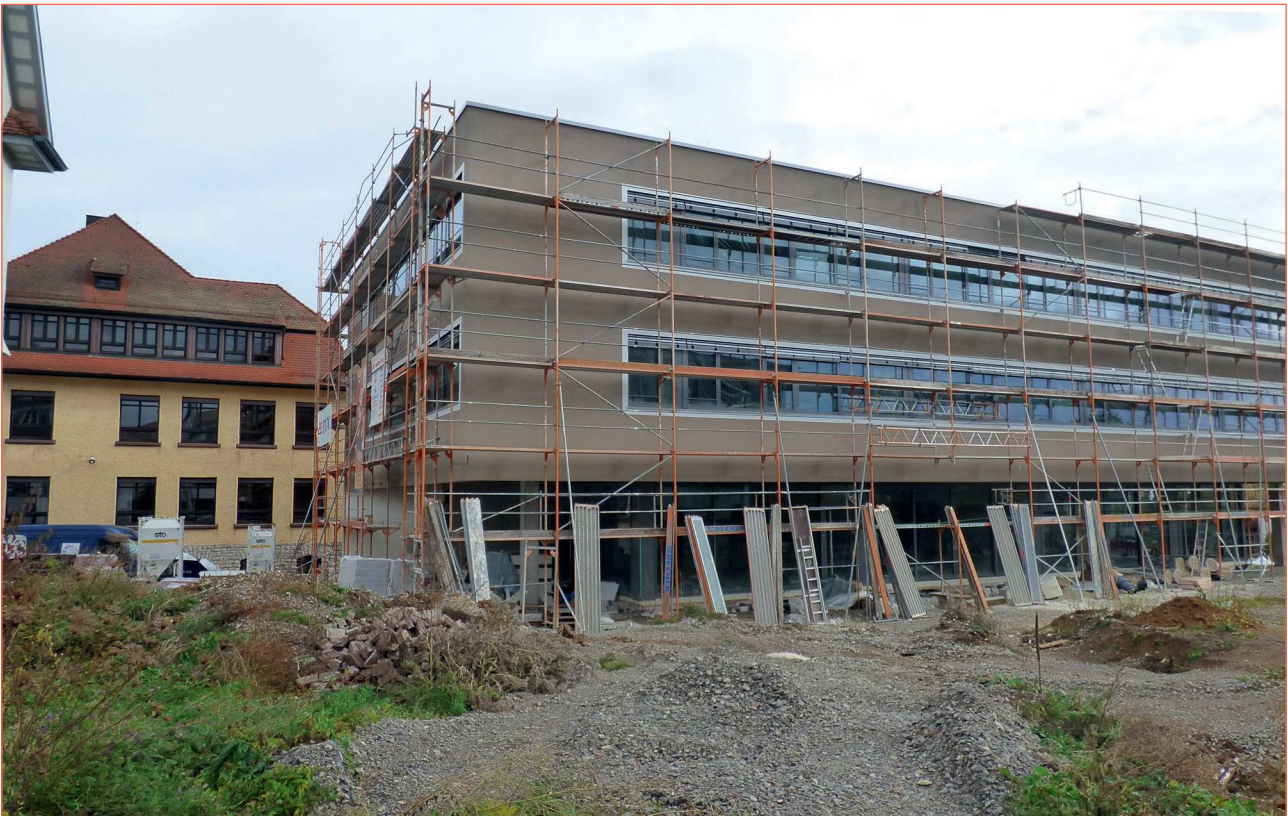
Schulneubau im November 2018
