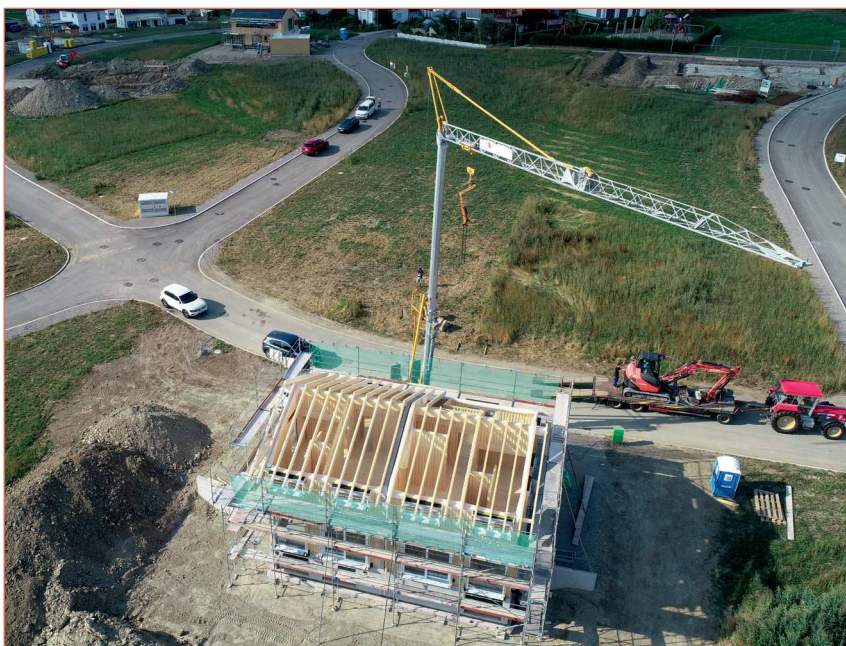
Neubau im Baugebiet Hüttensberg
