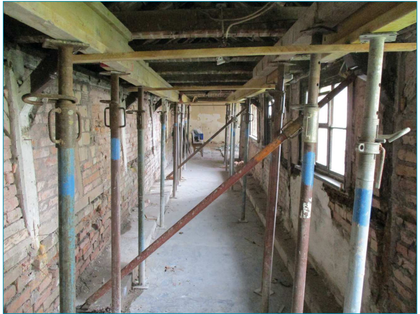
Kegelbahn Abstützung zur Einsturz- sicherung 2017
