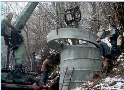
Versetzen des Reservoirs
