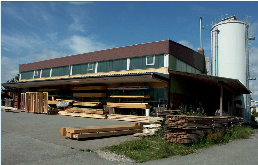
Betriebsgebäude von der Porschestrasse mit Halle und Silo
