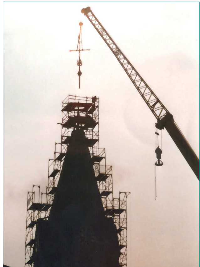
Das frisch renovierte Kreuz wird 1990 mit dem Autokran am Dunninger Kirchturm wieder angebracht.
