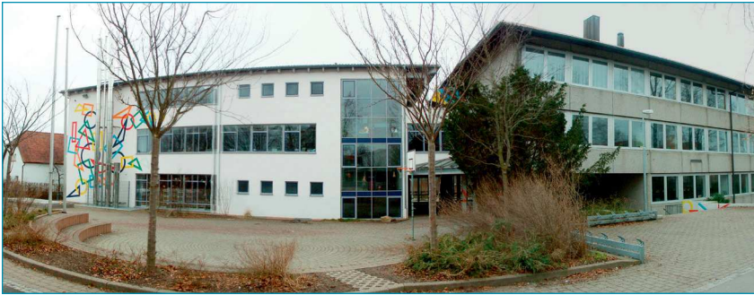
ESCHACHSCHULE MIT WESTBAU VOR DER SANIERUNG IM JAHR 2017
