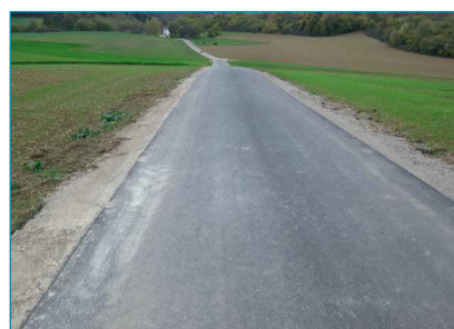
Die neu sanierte Hochwaldstraße
