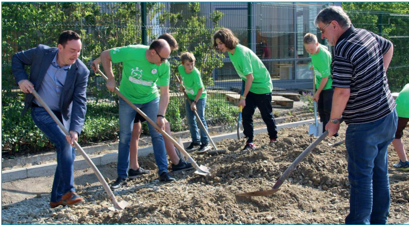
Arbeiten an der Boulebahn
