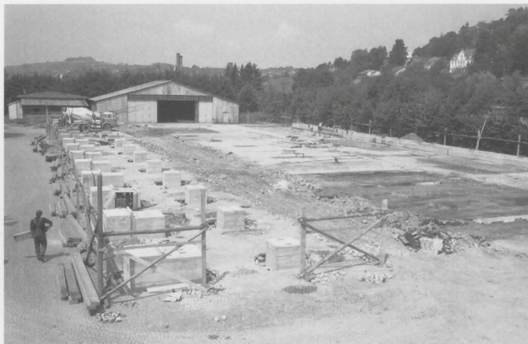
Die Baustelle der Eissport- halle. Im Hintergrund links der Schutterlindenberg.
