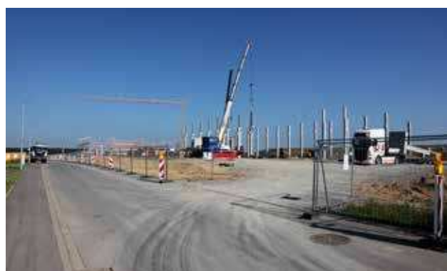
Die Gewerbefläche Kirchhören wird stark bebaut und wächst weiter
