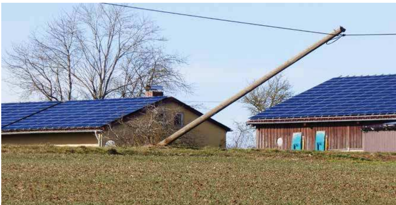
Auswirkungen vom Sturm Sabine, Februar 2020
