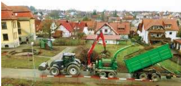
Der Baumbestand auf dem Bauplatz wird gehäckselt und gleich in der Hackschnitzelheizung energetisch verwertet (2017)
