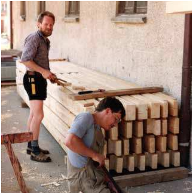
Herstellung der Festbühne mit Bauhof-Vize Hardy Brunnenkant (†), Bauhof im Sommer 1993
