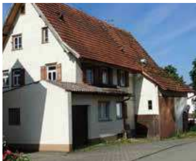
Ehemaliges „Holzer-Max“ Haus auf dem Brestenberg.
