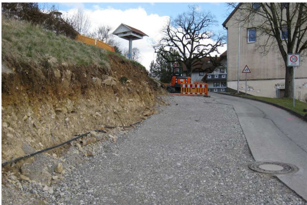
Kanalbaustelle am Schulberg
