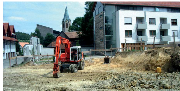
Baugrube Pflegeheim St. Veronika
