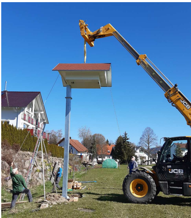
Aufstellen des Schwalbenhauses in Dunningen
