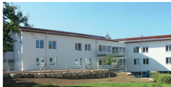
Das Pflegeheim St. Veronika ist fertiggestellt
