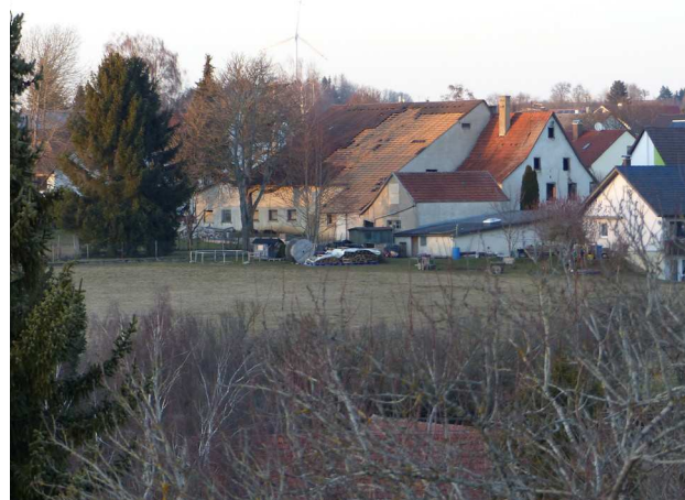
Abbruch des Bauernhauses der Fam. Haigis
