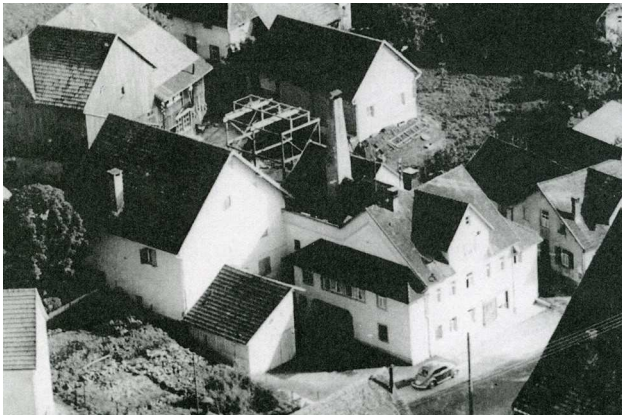
Luftaufnahme mit Gerüst in der Bildmitte
