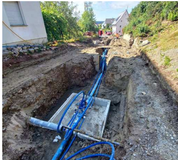
Bauarbeiten in der Grabenstraße in Dunningen
