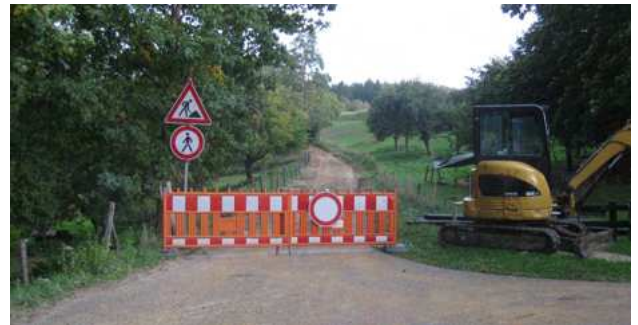
Bauarbeiten für den Funkturm
