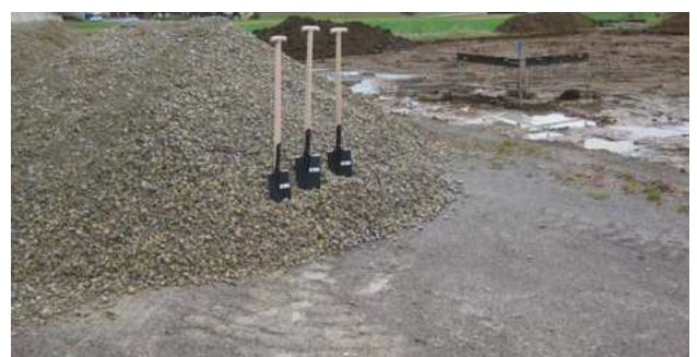
Spatenstich für den Vereinsschuppen
