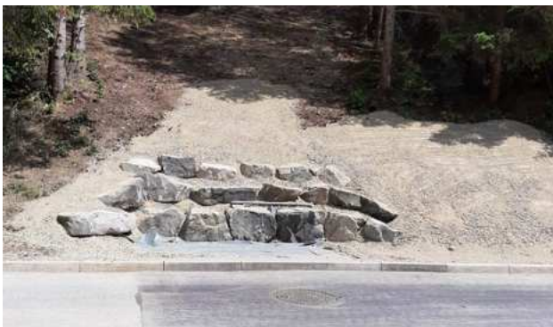
Trasse der Wasserleitung
