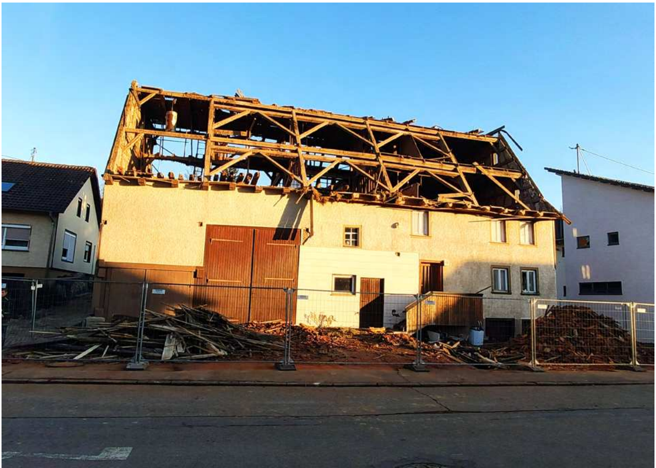
Februar 2023, Teilabbruch des Bauernhauses, Dorfbachstraße 19
