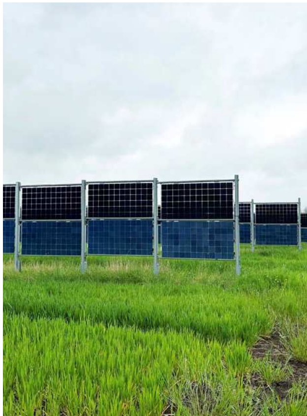
Anlage Solarpark bei Donaueschingen mit senkrechter Ausrichtung
