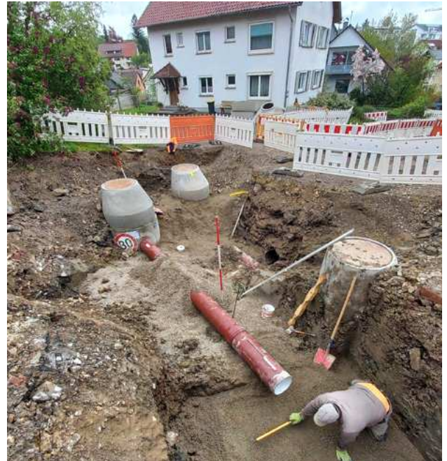
Bauarbeiten an der Kreuzung Haldenstraße/Grabenstraße
