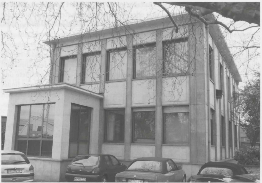
Bürogebäude Fa. Gaster Wellpappe, Kurpfalzring 113. Ansicht von Westen (Foto: Georg Machauer)
