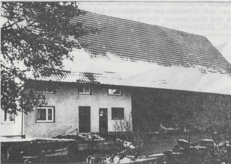
Nach den Bränden des 30-jährigen Krieges wurden hinter der Kirche wieder stattliche Bauernhöfe errichtet. Hier das Haus Magnus Mauch am unteren Friedhofweg.
