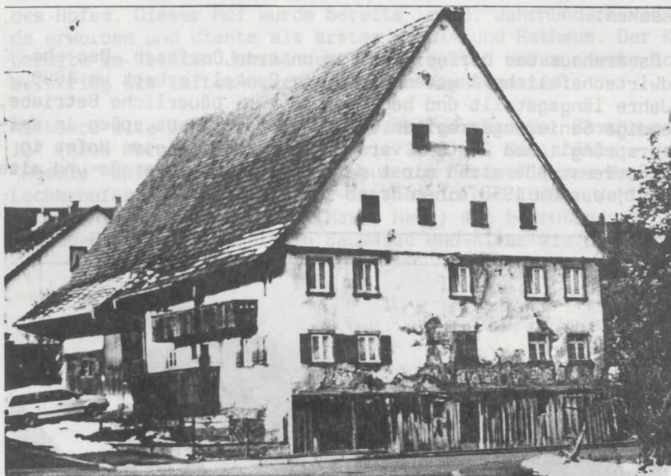
Das Haus Burri am Dorfbach wurde nach dem Großbrand von 1780 in seiner heutigen Form gebaut.
