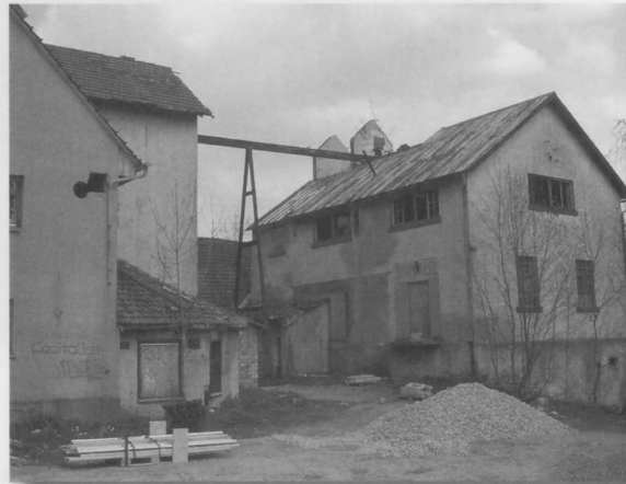
Ehemalige Mälzerei rechtes Gebäude ist das Getreidelager erbaut von Adolf Miller 1914
