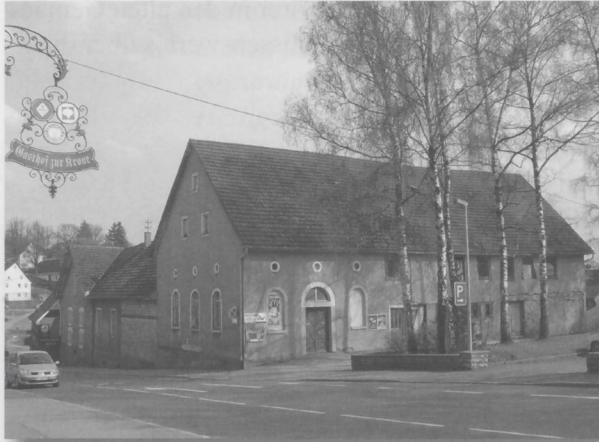
Ehemalige Brauerei zur Krone erbaut von Konrad Kleiner 1875
