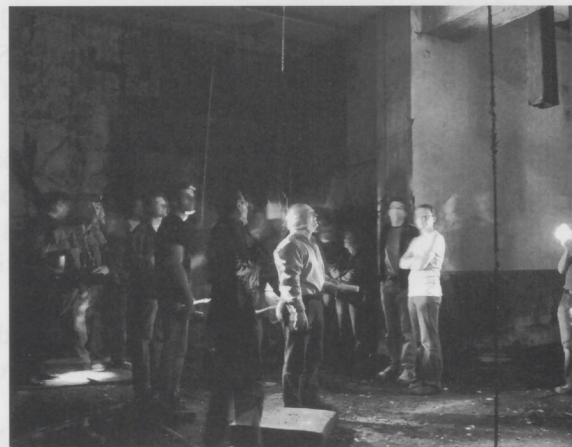
Lagerkeller im Bau von 1914
