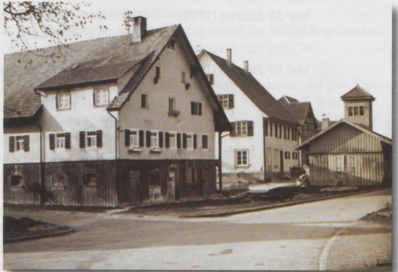
Hagenstall und Pumpstation in Dunningen
