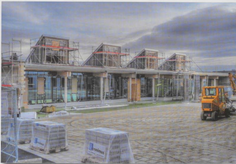
Blick auf die neue Sporthalle, vom Geschäftshaus aus
