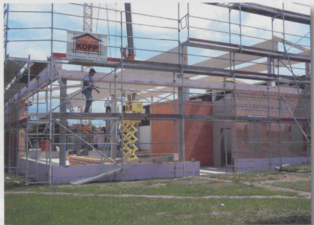
Pavillonanbau bei der Grundschule in Seedorf
