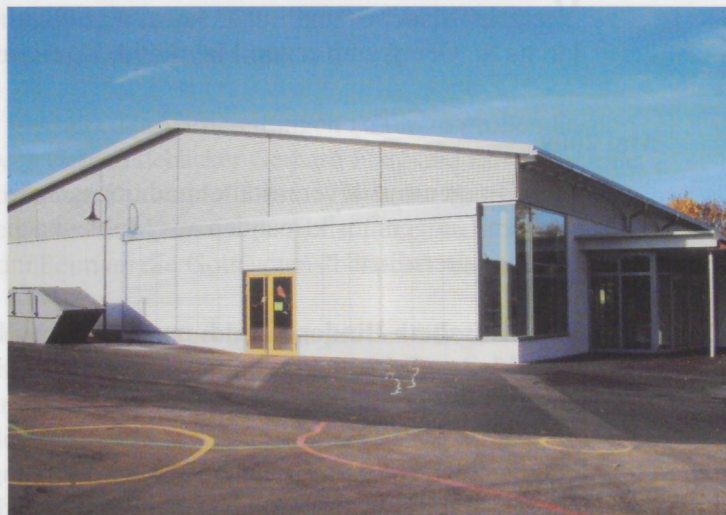
Pavillion Anbau an der Schule
