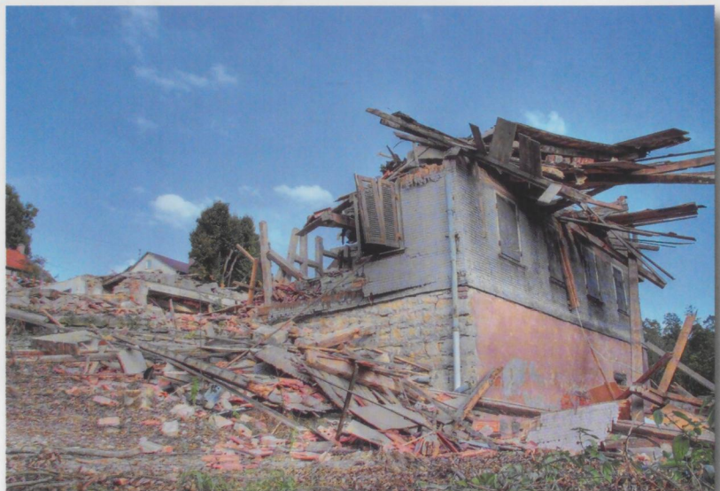
Der Eschachhof muss einem Neubau weichen
