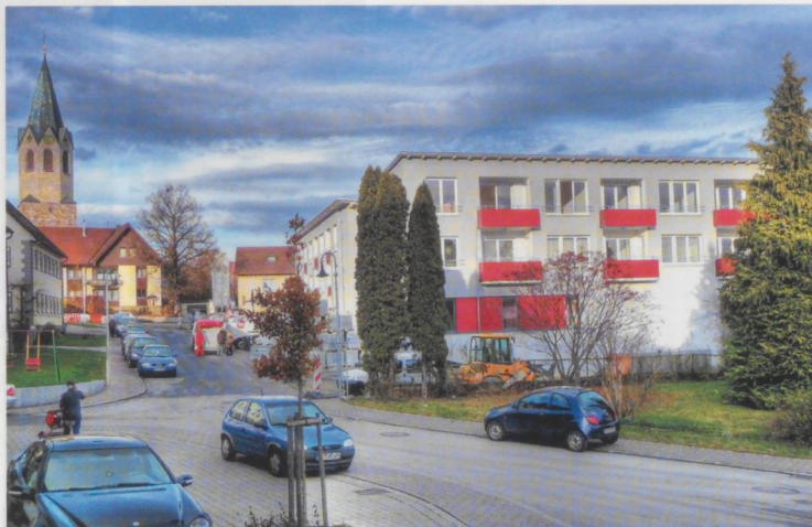
Neue Ortsmitte, Wohnheiten
