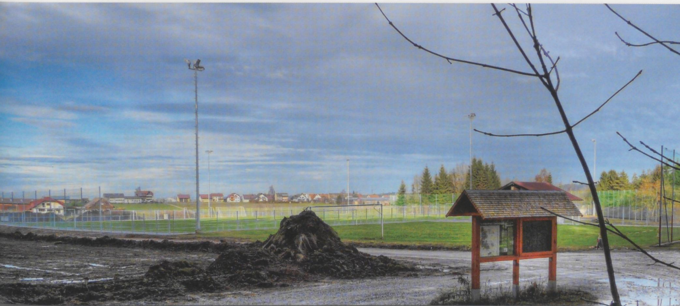
Neu errichtetes Sportgelände
