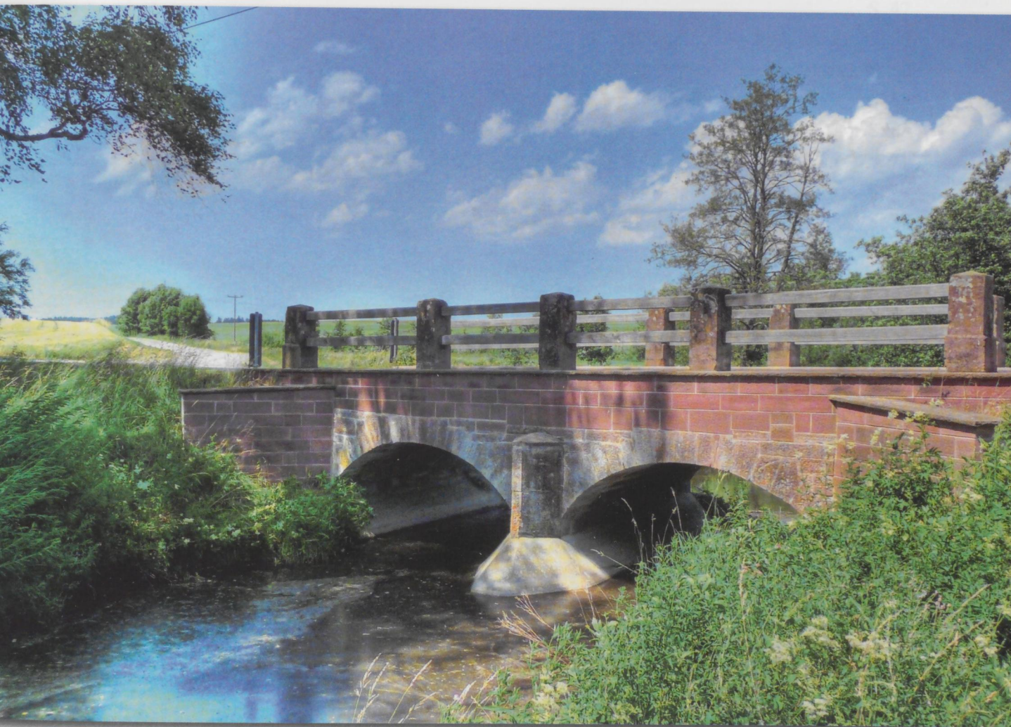
Käferbrücke über die Eschach (Fotograf: Fritz Rudolf)
