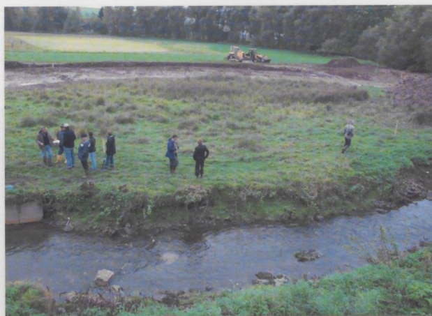
Eschachverlegung in Lackendorf
