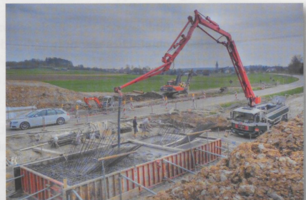
Die Umgehungsstraße ist im Bau
