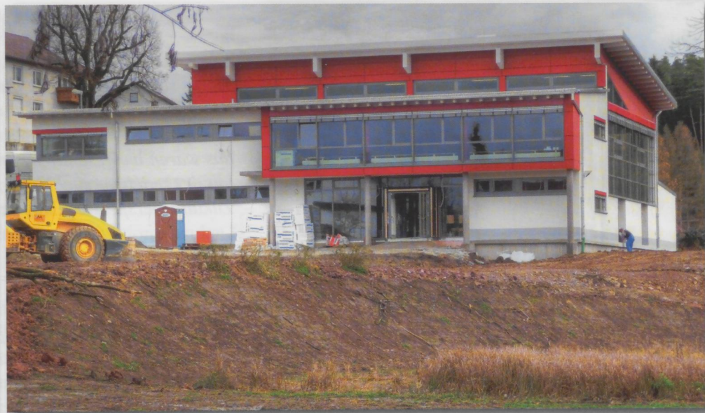
Bau der Eschachtalhalle in Lackendorf
