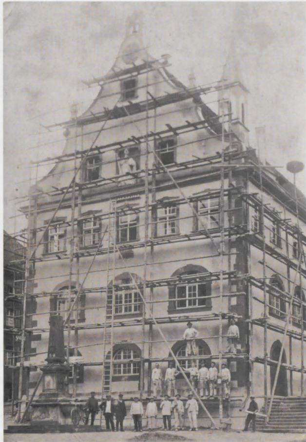
Abb.: Renovierungsarbeiten am Rathaus. Sammlung Gerd Blattmann / Repro: Wolfgang Hoffmann.
