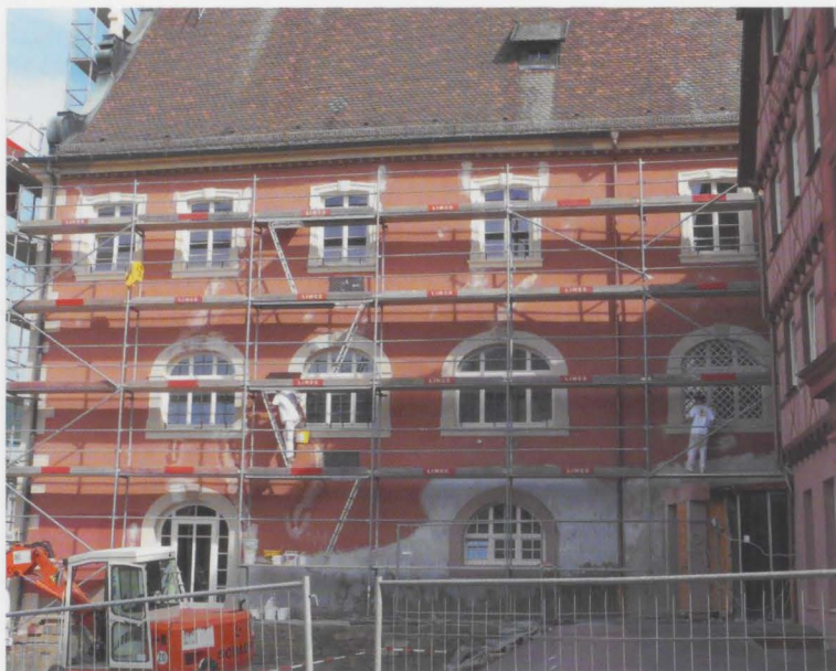
Die Westseite des Rathauses mit neuem Halbfenster und Eingang zum neuen Bürgerbüro „im Berg“. Aufn.: Bernhard Schlosshauer.
