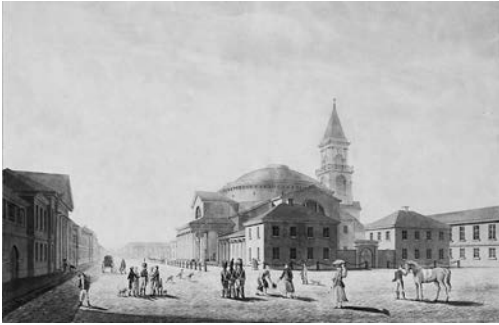
Schaubild der geplanten Gesamtanlage der Katholischen Stadtkirche mit Blick in die Erbprinzenstraße, 1808 (?) (saaal/fbB, Weinbrenner 30)
