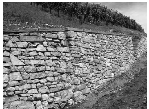
Sanierte Trockenmauer Gemeinde Ballrechten-Dottingen
