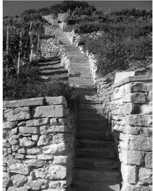
Treppe nach der Sanierung Gemeinde Ballrechten-Dottingen
