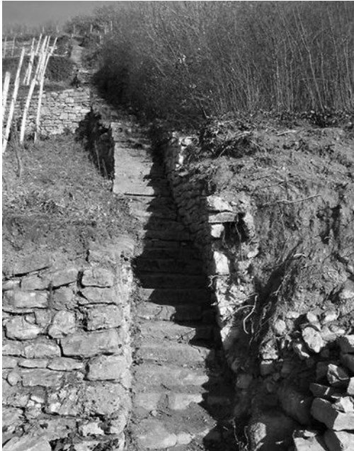
Treppe vor der Sanierung
