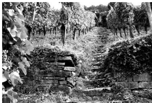
Weinberg vor der Sanierung
