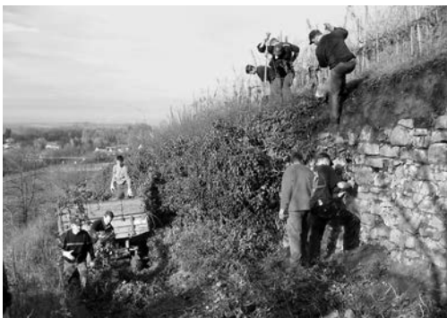
Freiwillige Helfer bei den Entbuschungsarbeiten
