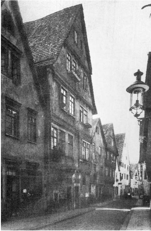
Nur noch Schutt und Asche. Keine Menschen mehr. Flösserviertel Obere Augasse Pforzheim vor dem Kriege. Am 23. 2. 1945 durch Bombenagriff zerstört.
