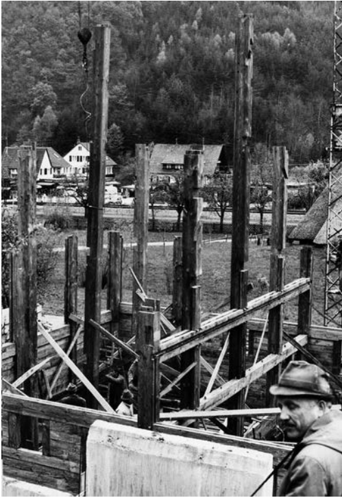
Schwarzwälder Freilichtmuseum Vogtsbauernhof. Der „Säulenwald“ des Schauinslandhauses. Die letzte „Firstsul“ ist eingefahren und wird gerade festgesetzt. 29. 4. 1981.
