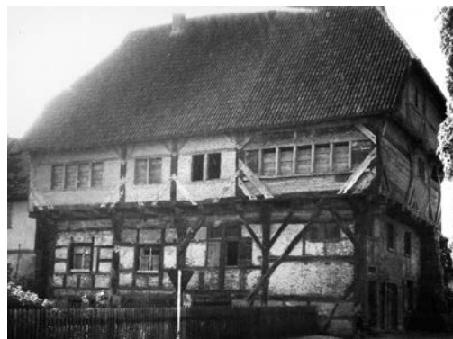
„Altes Haus“ Pfullendorf. Im Oberen Linzgau, ältestes Fachwerkhaus Südbadens, um 1400. Die Südansicht 1956 vor der Instandsetzung zeigt die technischen Merkmale der ursprünglichen alemannischen Abzimierung. Foto: E. Kiehle
