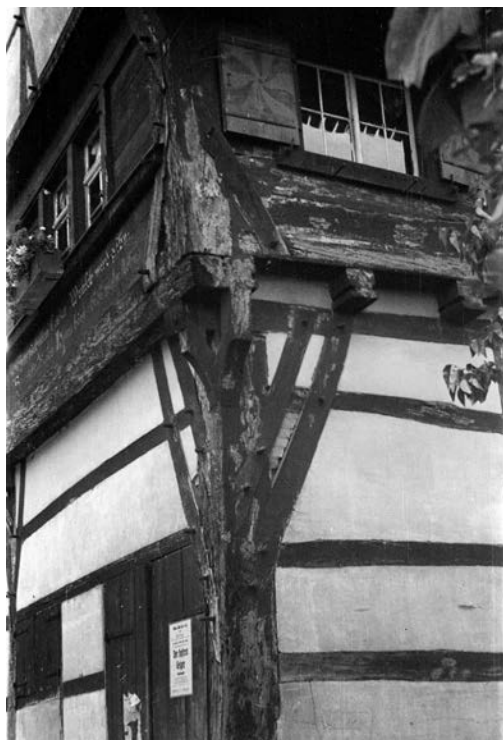
Immenstaad am Bodensee. Die Ecke der ehem. Pulvermühle, Hauptstrasse 87, um 1500. lässt im Zustand von 1949 deutlich die alte sog. alemannische Bauart erkennen.
